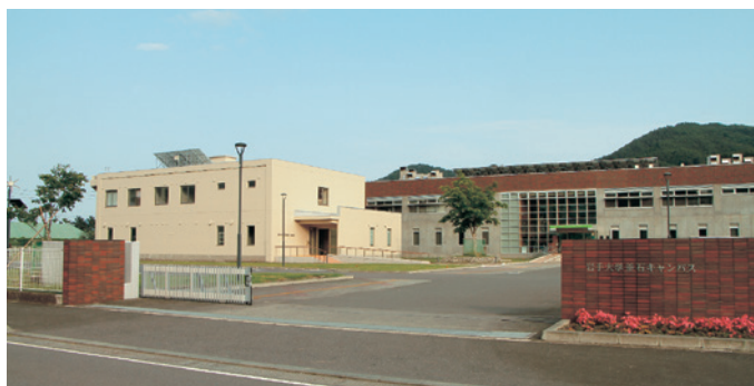
完成した総合教育研究棟(水産系)(左の建物)
