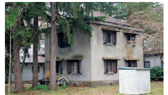
現在の収蔵庫(2023(令和5)年) 一北東側から撮影
