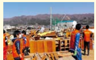
4月6日～ 大船渡小学校での瓦礫撤去作業
