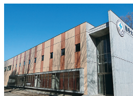
動物病院新棟
