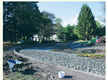
改修工事中 平成26年10月9日撮影
